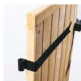
Volet Gardois, penture inversée et emboîture
